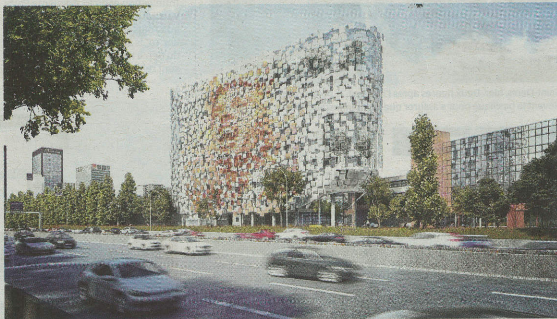
La façade du bâtiment LiVE sera composée de plus de 3 000 éléments métalliques perforés. Grâce aux leds insérées dans ces « écaïlles », des images pourront habiller la façade de l'immeuble.
